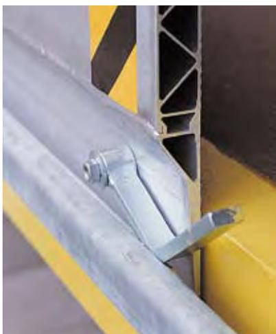
Au repos, le pont est maintenu en position verticale grâce à un loquet de verrouillage.
