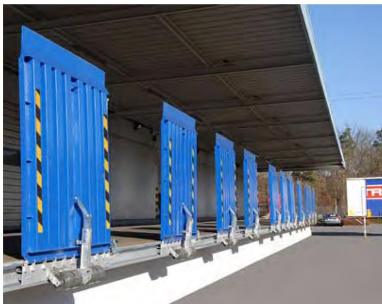
*Les ponts en acier, type FBSS (modèle fixe, à souder) ou FBSV (modèle coulissant, à monter dans un rail à souder), ont une capacité de charge de 5000 kg en standard et de 6000 kg en option.*
